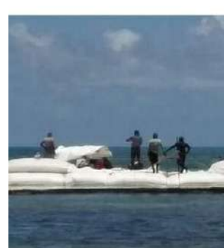
Arrecife de Concreto
