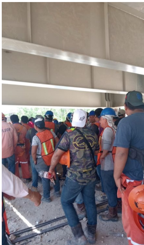
Personal de obra bajo el viaducto.
